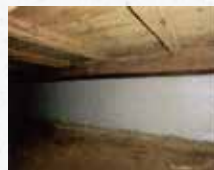
アラミドシートの上からパワーアラストを施工します。
